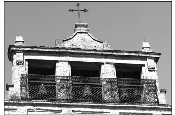
Il campanile con le grate in ferro battuto
